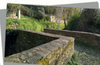
11-Puente Medieval y Tenería
